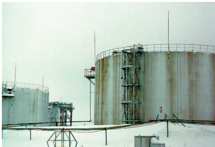
Рис. 1. Общий вид резервуарного парка
