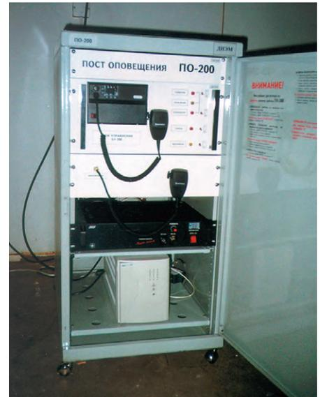
Рис. 2. Системный блок поста оповещения с открытой дверцей
