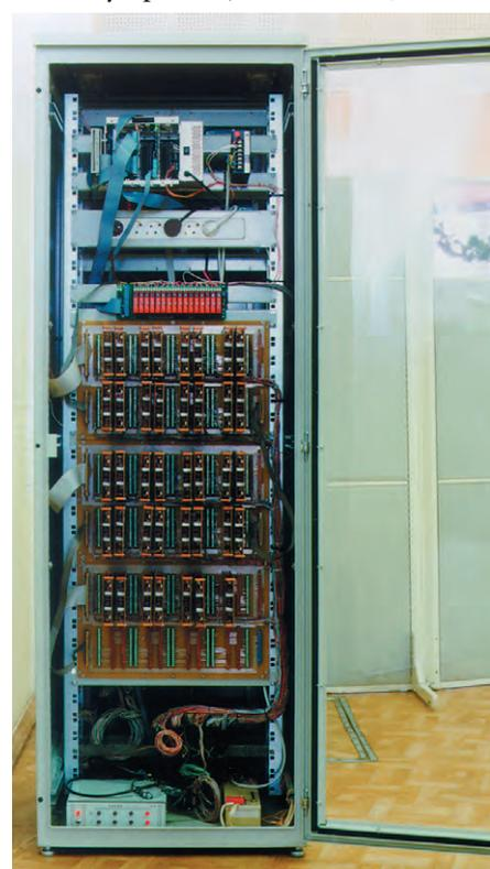
Стойка для подключения к станционным устройствам автоматики
