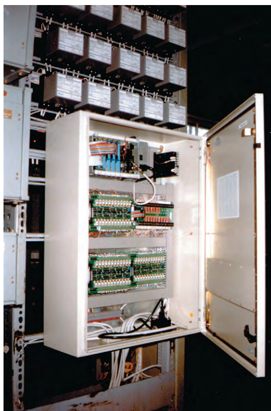
Рис. 3. Основной блок «Нева» с открытой дверцей
