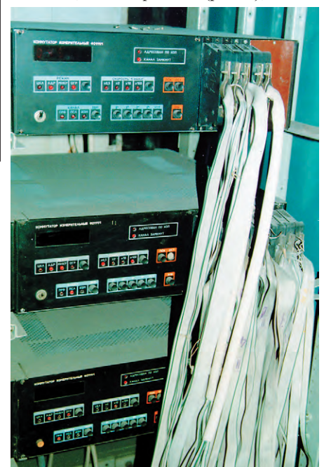
Рис. 4. Шкаф аналоговых коммутаторов Ф2111
