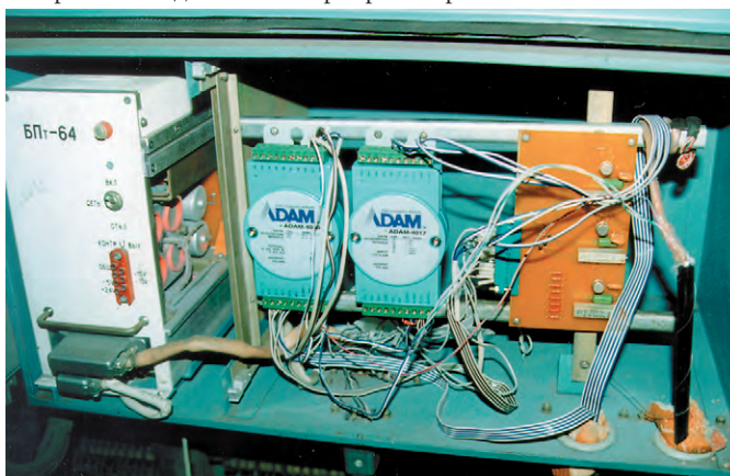
Рис. 3. Модули связи с объектом
