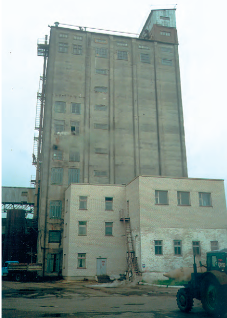
Главный производственный корпус ОАО «Жабинковский комбикормовый завод»
