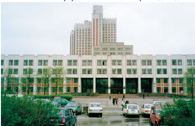
Здание Российской Академии госслужбы, где внедрена система управления инженерным оборудованием на базе UltraLogic
