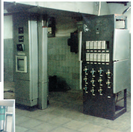
Так выглядела старая система управления тепловым пунктом
