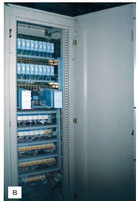
Рис. 7. Щиты управления: а — щит местного управления, б — щит электропитания, в — щит функциональных блоков
