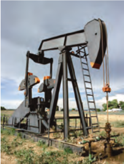
Рис. 1. Традиционная насосная установка
