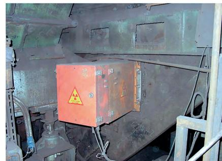
Рис. 2. Установка датчика в весовой воронке доменной печи
