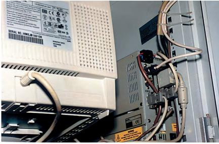
Рис. 5. Вид монтажного шкафа ИСР сзади (справа — промышленный компьютер)
