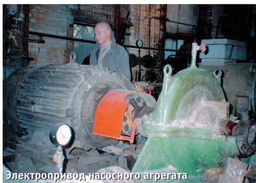
Электропривод насосного агрегата
