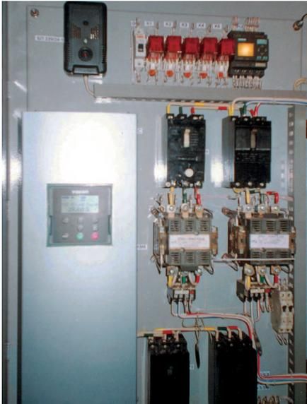
Комплектная система с частотным регулированием в одном шкафу
