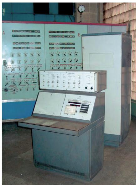
**Рис. 4. Пульт управления системой, встраиваемой на доменной печи № 2 ОАО «Испат-Кармет»**
