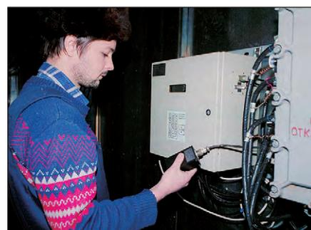
**Рис. 5. ИВУ стационарной системы «Поток-3М» в блок-боксе**
