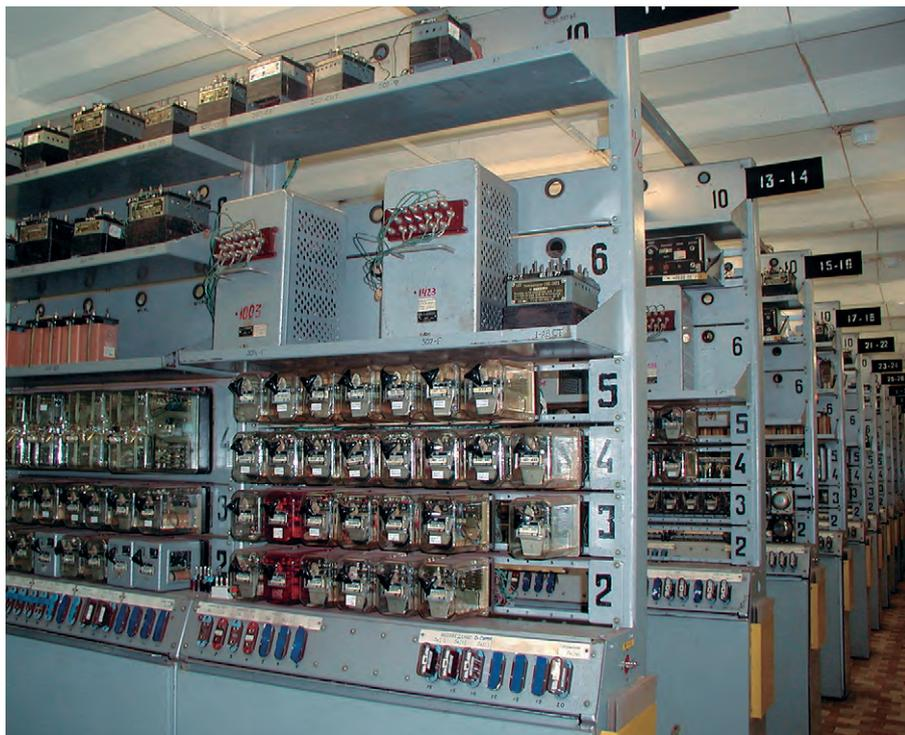
Рис. 2. Общий вид помещения АТДП (аппаратуры телемеханики и управления движением поездов) со старым оборудованием (зона ответственности — около 500 м пути в пределах станции и 3 стрелки)
