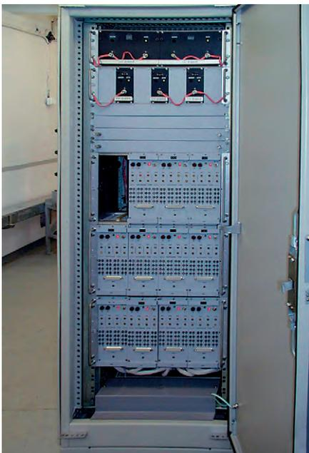
Рис. 8. Стойка СТФ аппаратуры ФМ-канала
