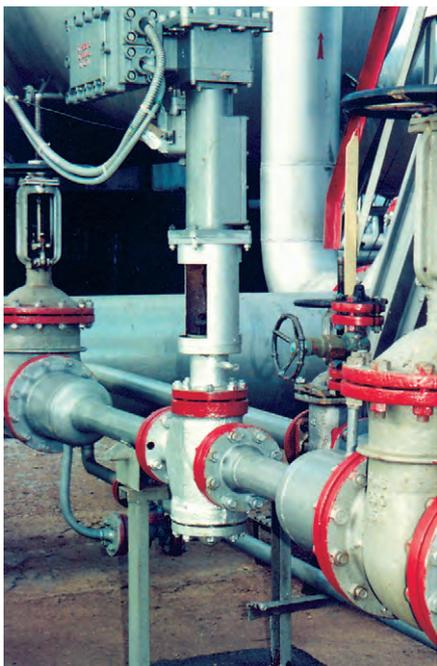
Рис. 4. Исполнительный механизм — электрифицированная задвижка
