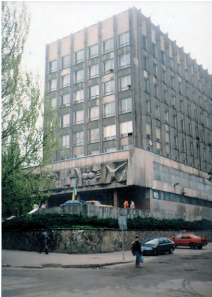
Здание электротехнического факультета ДонГУ
