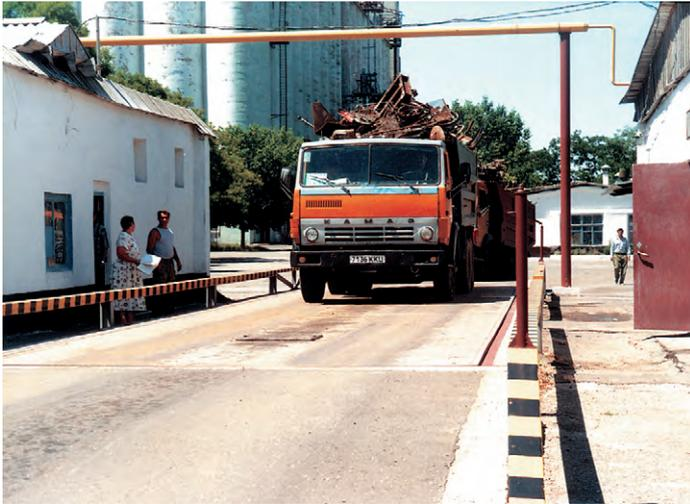
Рис. 5. Ейский портовый элеватор: автомобильные весы 2РС60-ДА
