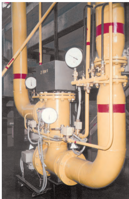
Рис. 2. Запорный клапан блока газооборудования БГ-5
