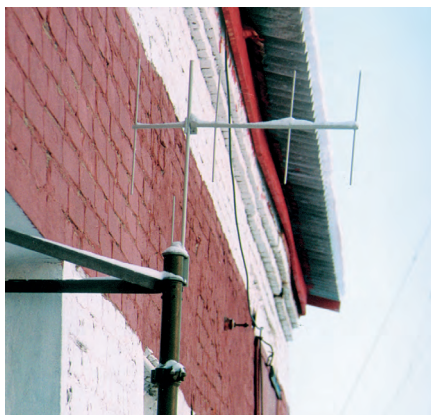
Рис. 6. Антенна, используемая для передачи данных по радиоканалу
