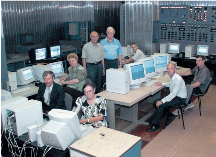
Рис. 4. Диспетчерский зал отделения теплопрочностных испытаний
