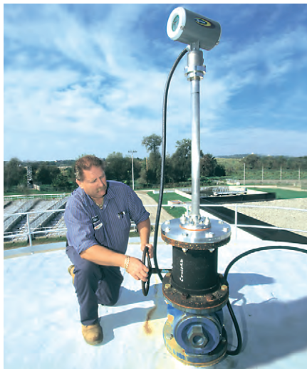
Рис. 4. При использовании скользящего волновода радарный уровнемер можно установить, эксплуатировать, проверять и обслуживать без разгерметизации резервуара
