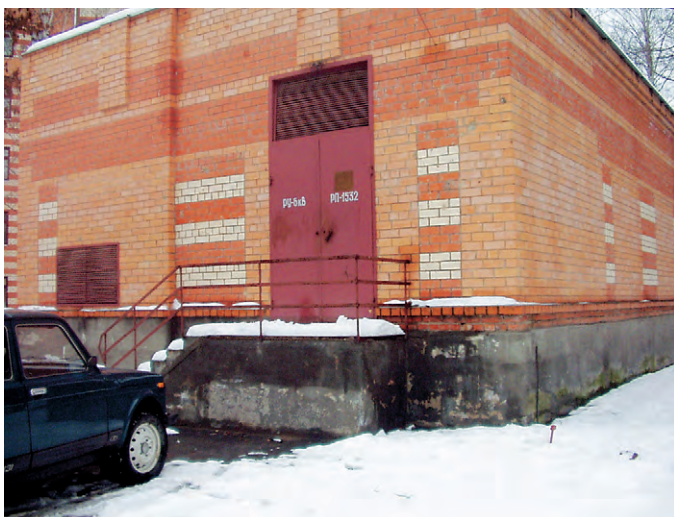
Здание распределительного пункта электросети
