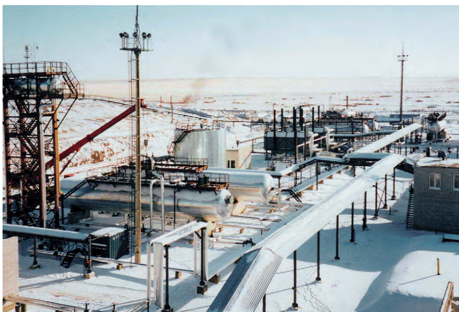
Рис. 1. Общий вид установки комплексной подготовки нефти
