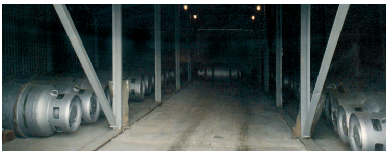
Рис. 1. Расходный склад жидкого хлора и вид хранилища изнутри
