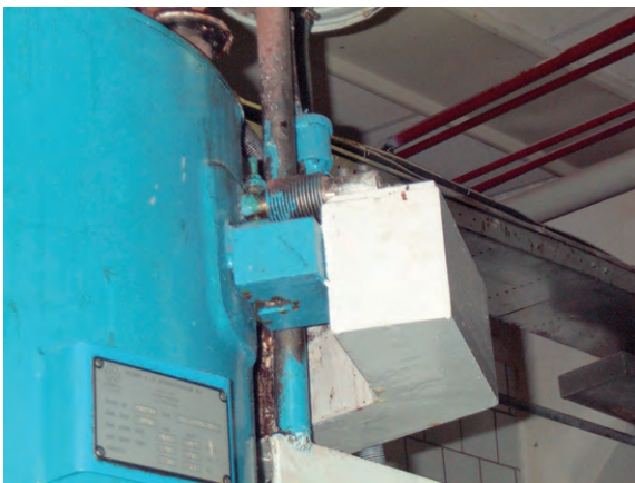
Рис. 9. Расположение тензодатчика весовой станции
