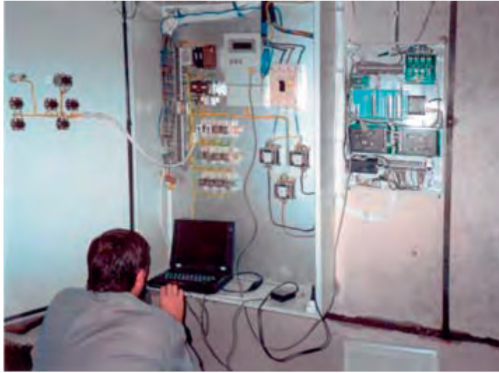
Рис. 11. Рабочий момент настройки оборудования с помощью комплекса технического мониторинга в одном из тепловых пунктов города Калининграда
