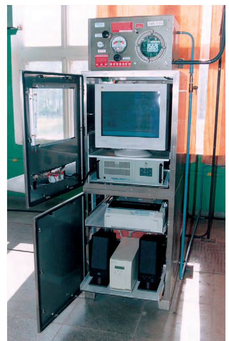
Рис. 5. Размещение вычислительного оборудования во взрывозащитном шкафу
