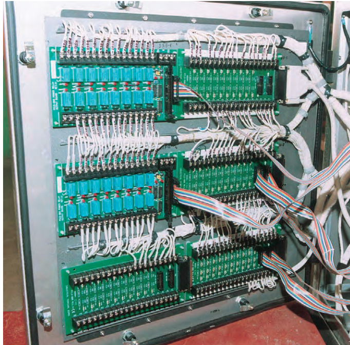
Рис. 2. Подключение сигналов через клеммные платы
