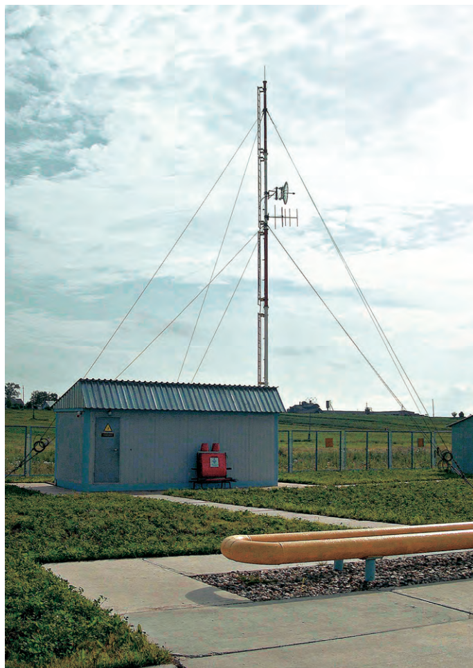
Рис. 2. Блок-бокс контролируемого пункта газораспределительной станции
