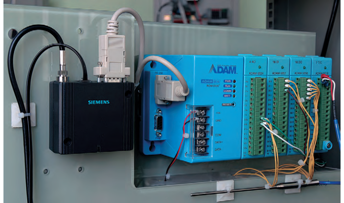
Рис. 4. Подключение модема MC35 Terminal к контроллеру ADAM-5000
