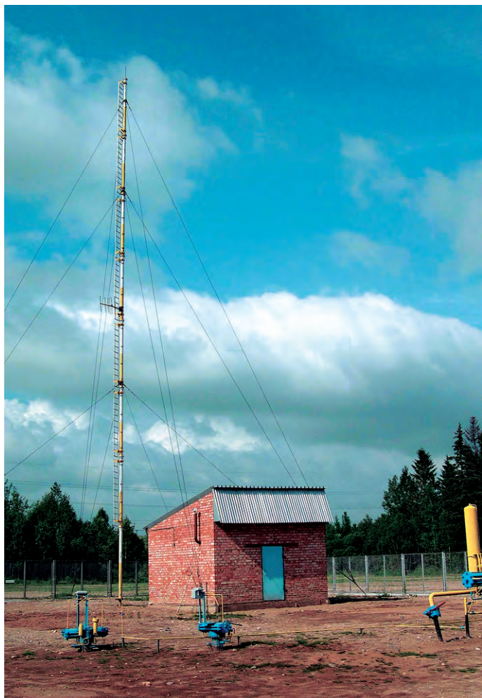
Рис. 1. Блок-бокс контролируемого пункта кранового узла
