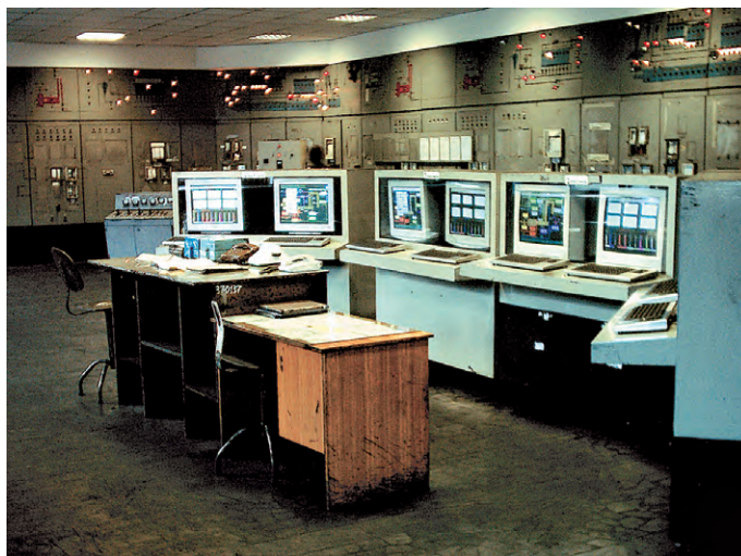
Рис. 5. Операторская цеха № 1 НКТУ: рабочие станции попарно (основная и резервная) размещены в пультах с принудительным нагнетанием чистого воздуха для защиты от сажевой пыли
