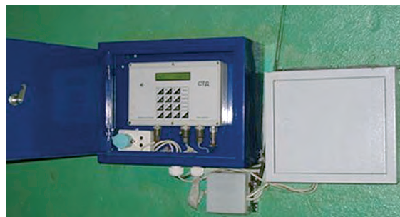
Рис. 1. Узел системы с теплосчётчиком STD-3
