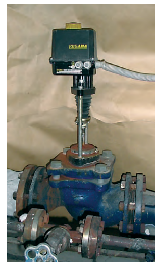
Рис. 2. Запорно-регулирующий клапан подачи пара
