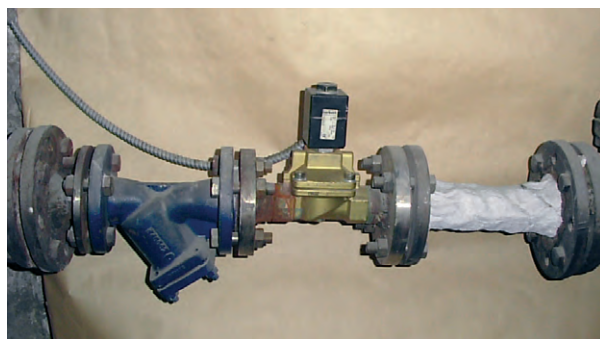
Рис. 3. Электромагнитный клапан подачи пара в камеру
