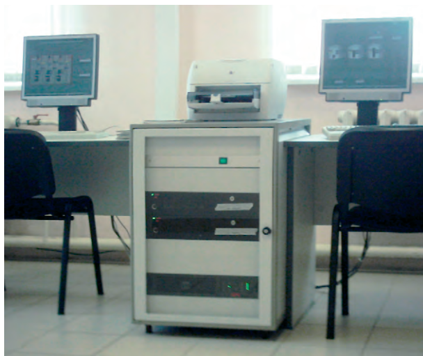
Рис. 8. Шкаф с индустриальным компьютером IPC-610, источником бесперебойного питания и выдвижной клавиатурой в помещении диспетчерского пункта
