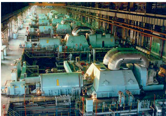
Рис. 1. Энергоблоки 200 МВт
