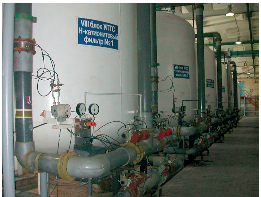
Рис. 2. Блок фильтров
