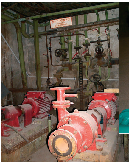
Рис. 5. Преведенная насосная в состоянии демонтажа
