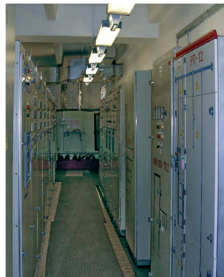
Рис. 2. Автоматы ввода резерва и распределители нагрузки
