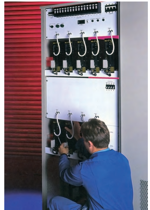
Система аварийного электропитания для необслуживаемых морских нефтяных платформ
