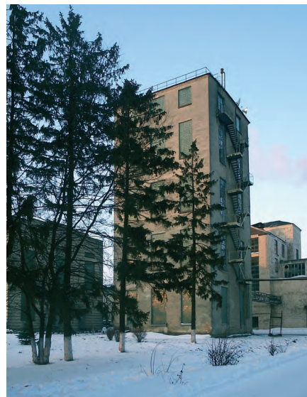
Козловский спиртовой завод, здание брагоректификационной установки
