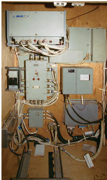
Монтаж аппаратуры ЕКС на электровозе ЧС2
