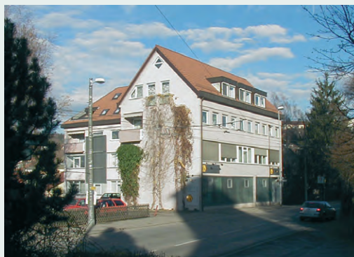
Здание главного офиса компании Pepperl+Fuchs EXTEC GmbH
