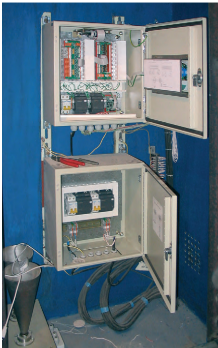
Рис. 5. Монтаж блоков Б1-БАРС 322 и БП-120
