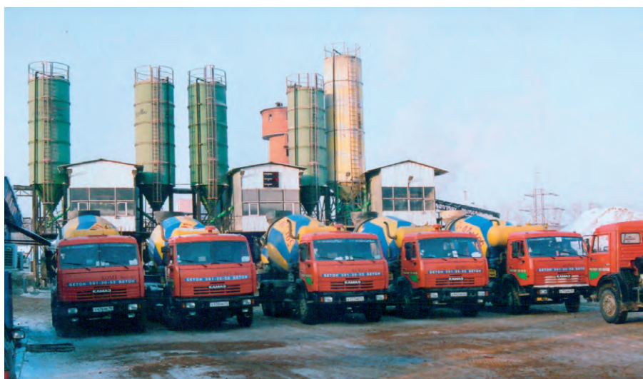
Бетонный завод ООО «Торговый Дом Одинцово»
