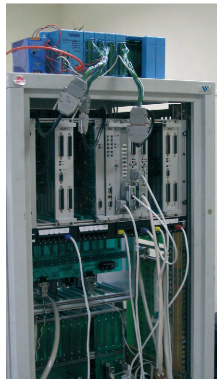
Рис. 2. Подключение микроконтроллера АДК к проверяемому оборудованию КП
