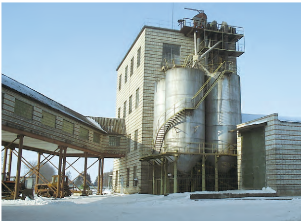
Рис. 1. Здание размольного участка ГП «Козловский спиртовой завод»
