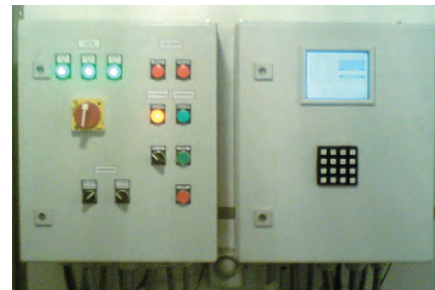
Рис. 6. Комплект управляющего оборудования для подогревателя нефти
