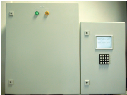
Рис. 5. Комплект управляющего оборудования для системы подогрева воды
