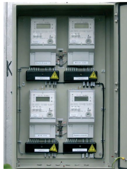
Рис. 3. Вариант установки счётчиков электрической энергии на энергообъекте
