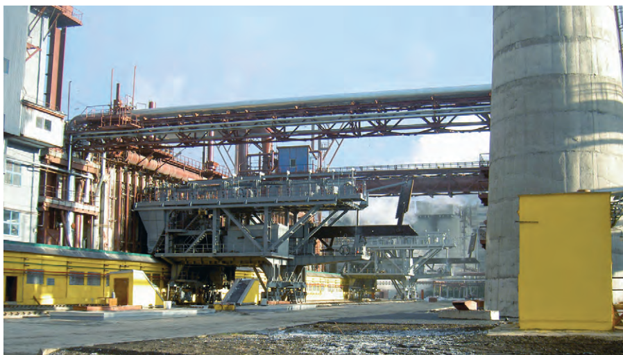
Рис. 1. ОАО «Алтай-Кокс»: коксовая батарея № 5
