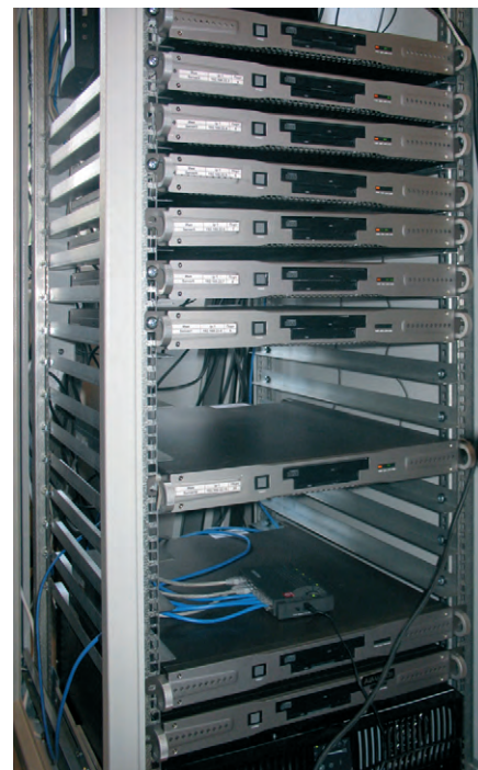
Рис. 4. Стойка серверов Fastwel AdvantiX, установленная в ЕДЦ (этап монтажа стойки)
