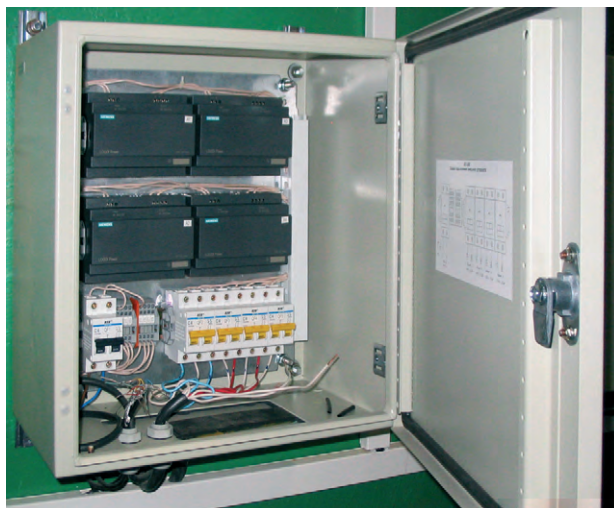
Рис. 7. Монтаж блока БП-240
