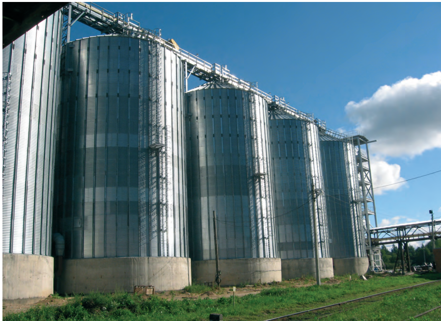
Рис. 1. Силосный корпус элеватора
