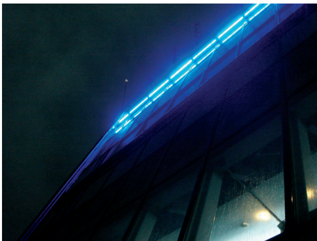
Рис. 1. Фрагмент подсветки здания Газпрома в Москве с помощью светильников, выполненных на основе светодиодов Cree
