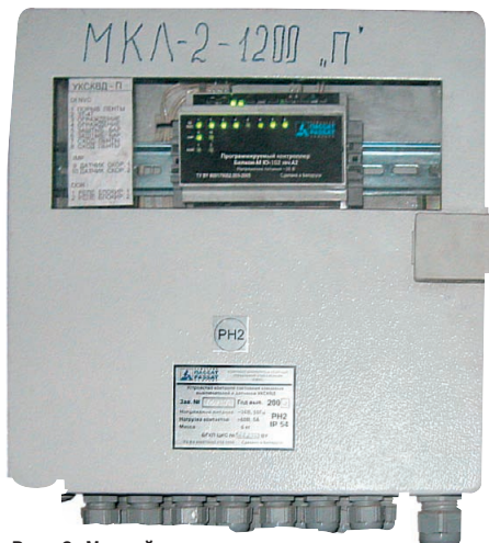
Рис. 2. Устройство контроля состояния концевых выключателей и датчиков
