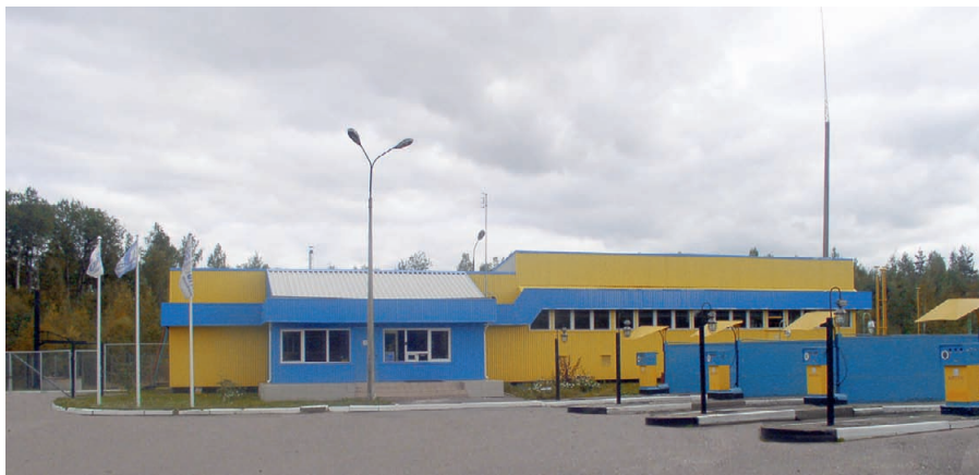
Рис. 1. Автомобильная газонаполнительная компрессорная станция в городе Тосно (Ленинградская область)
