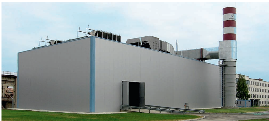
Рис. 1. ГТ ТЭЦ серии ГТ ТЭЦ-009 «Энергомаш» (энергетический комплекс в г. Крымске)
