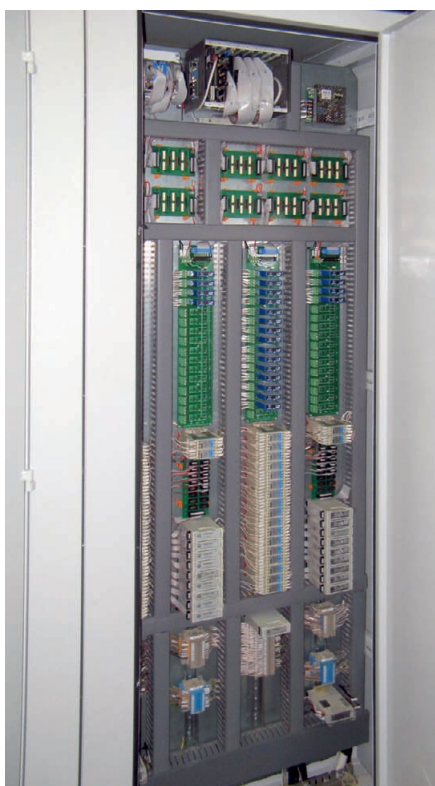
Рис. 4. Монтаж аппаратных средств АСУ
