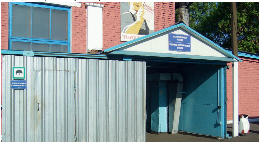
Рис. 8. Вторая система управления, идентичная описанной в статье, установлена на воротах подсобно-заготовительного участка
