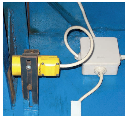
Рис. 5. Датчик крайнего положения ворот
