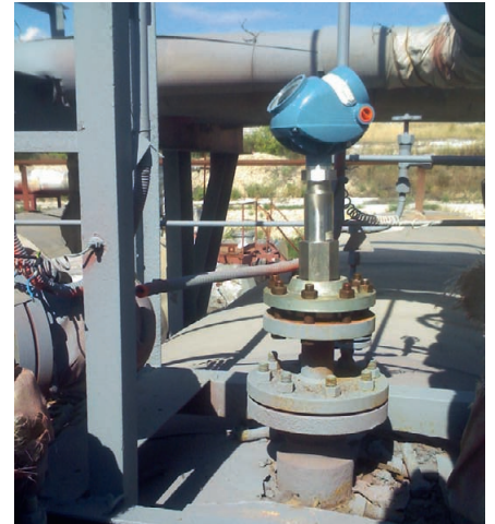
Рис. 3. Rosemount 5300 установлен взамен отказавшего буйкового уровнемера на ёмкости со сжиженным аммиаком
