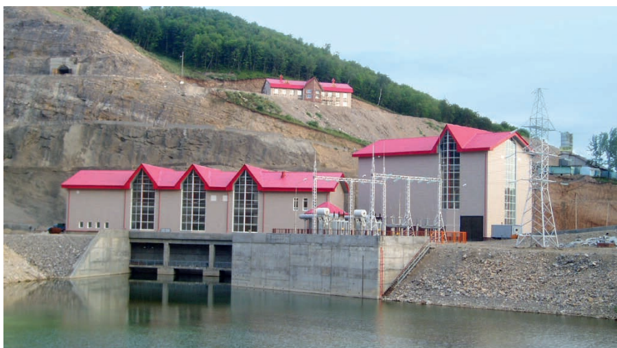
Рис. 1. Общий вид Юмагузинской ГЭС
