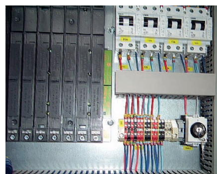
Рис. 7. Шкаф AD-D: установка автоматов защиты
