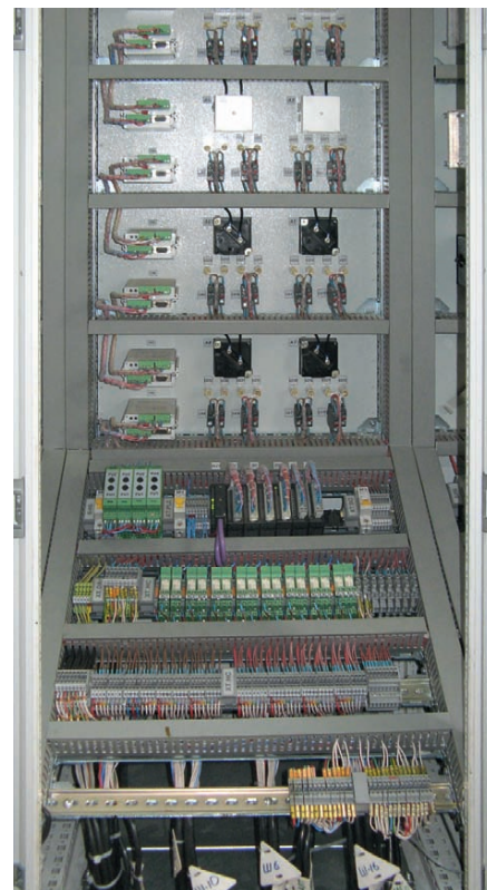
Рис. 4. Секция контроля и управления электродвигателями
