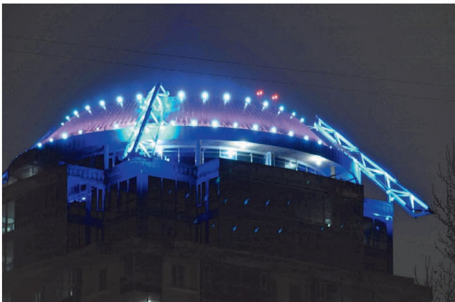
Рис. 4. Подсветка жилого комплекса «Кутузовская Ривьера» (г. Москва) прожекторами на основе светодиодов компании Cree
