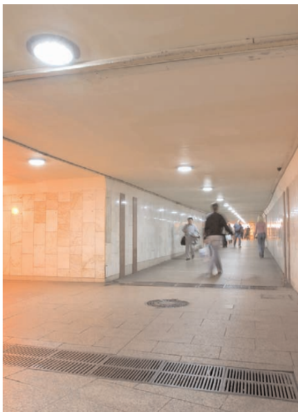
Рис. 3. Освещение подземного пешеходного перехода около станции метро «Рижская» (г. Москва) светильниками на основе светодиодов Cree (прямо) и натриевых ламп высокого давления (слева)
