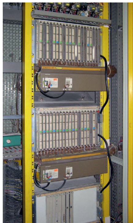
Рис. 1. Стойка контроллера (внизу) и стойки расширения 1 и 2
