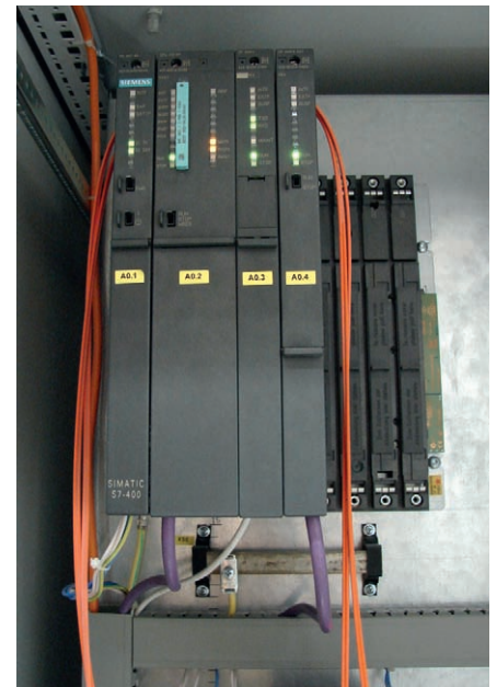
Рис. 5. Программируемый логический контроллер системы МПЦ
