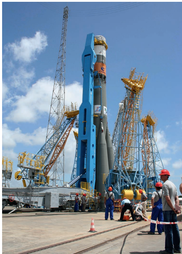
Рис. 1. Установка РН «Союз» в стартовую систему ГКЦ
