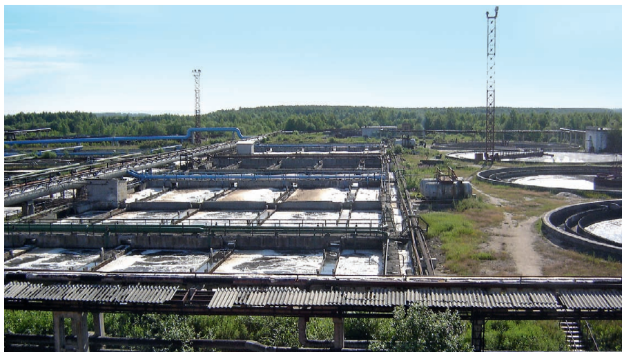
Рис. 1. Общий вид территории станции биологической очистки
