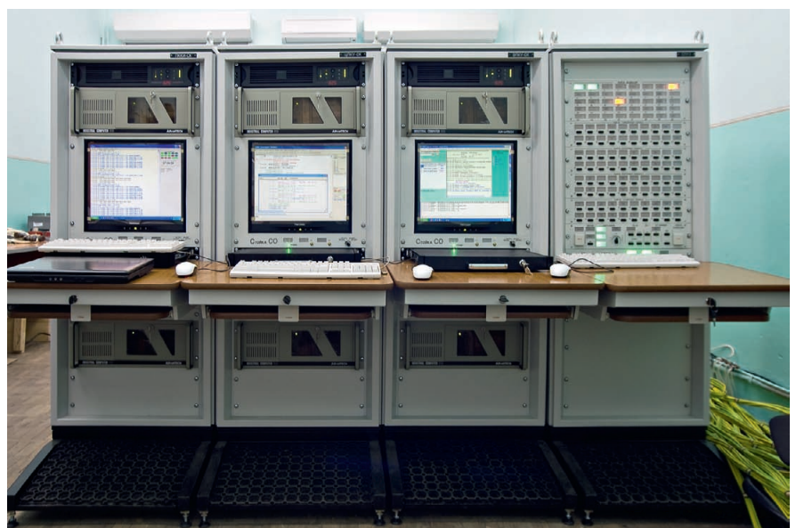
Рис. 4. Вычислительный комплекс АИС
