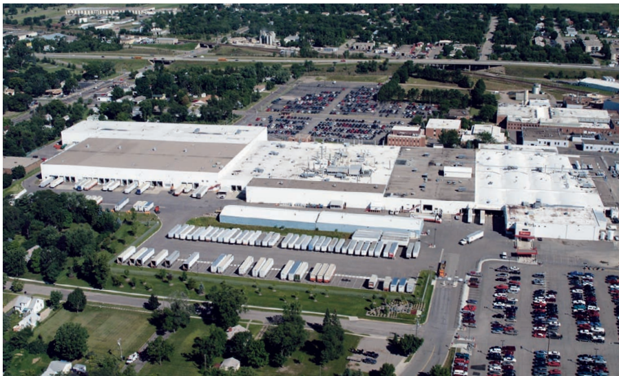
Рис. 2. Производственная площадка Pentair Technical Products в г. Анока (штат Миннесота)
