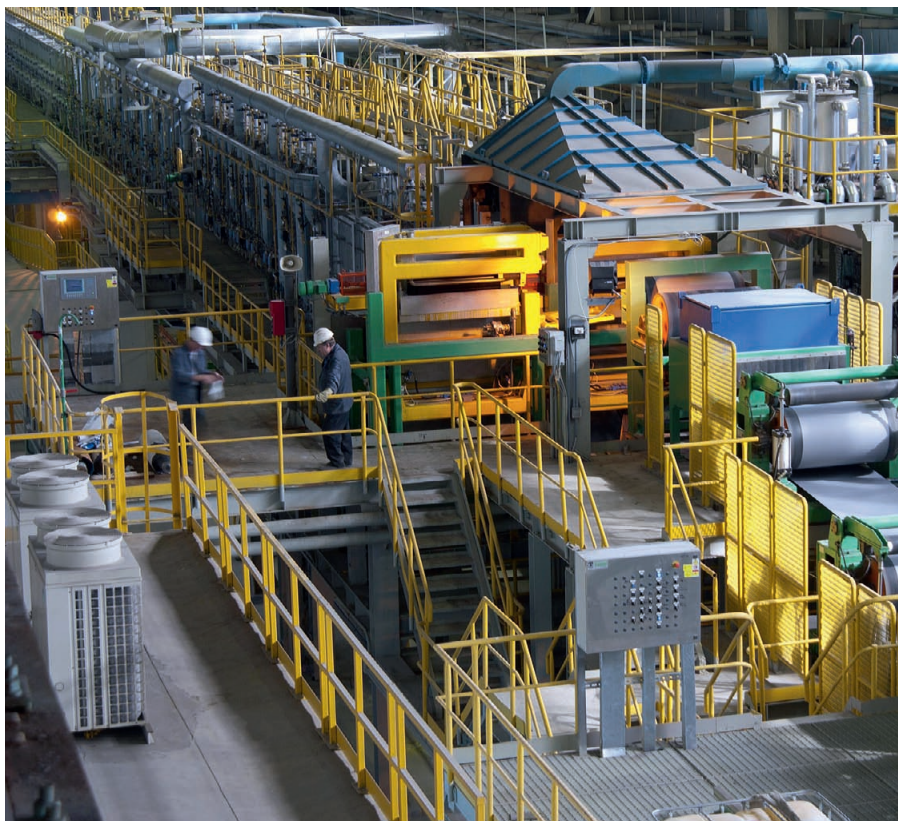
Рис. 1. Выходная часть агрегата выпрямляющего отжига
