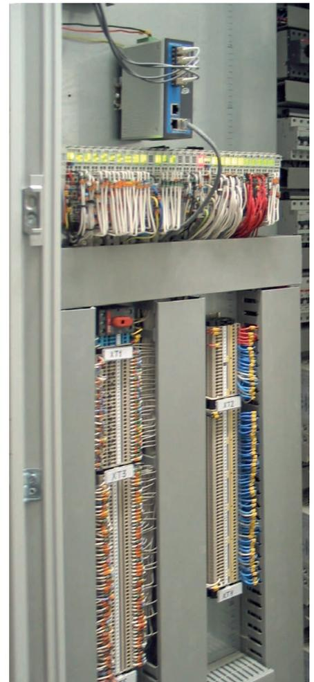
Рис. 5. Щит управления для шести ВУ с рециркуляцией и четырёх вытяжных ВУ
