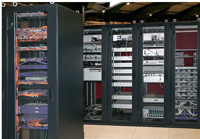
Рис. 4. Шкафы контроля и управления в сервисной зоне базируются на каркасе Slim-Line, выдерживающем нагрузку до 400 кг
