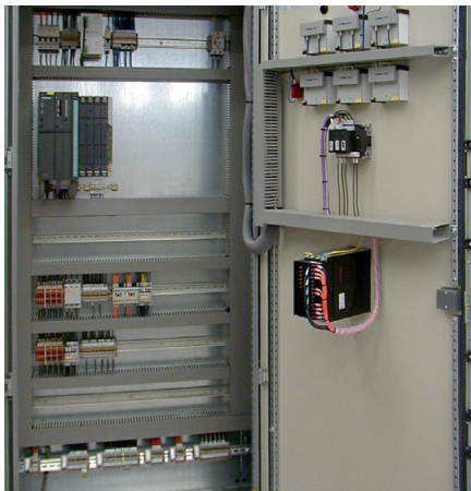
Рис. 3. Контроллер S7-400 на этапе монтажа в шкаф управления
