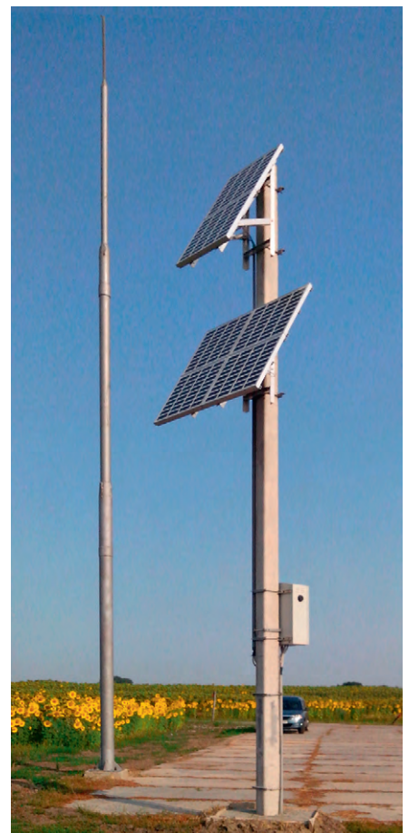
Рис. 5. Внешний вид оборудования автоматизации скважины
