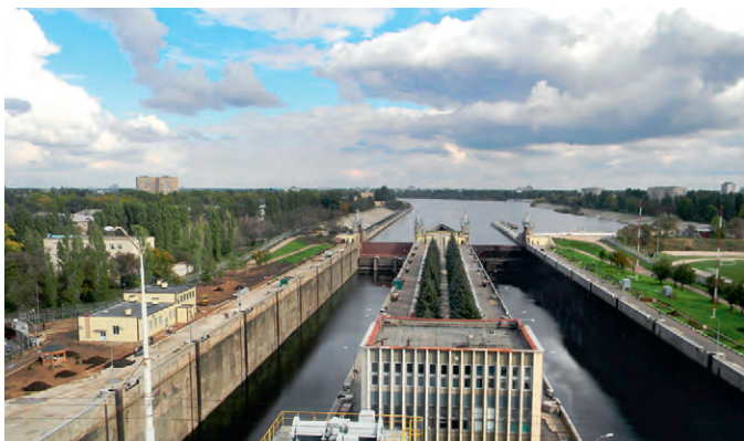
Рис. 3. Вид на шлюзы с поста управления
