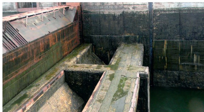
Рис. 4. Вид на ВРВ со стороны камеры шлюза. Ворота находятся в положении «Закрыто»
