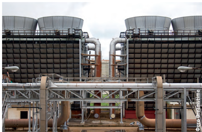
Рис. 3. Вентиляторная градирня
