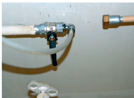
Рис. 6. Присоединение пневмосистемы экспериментального стенда к магистральному трубопроводу пневмолинии
