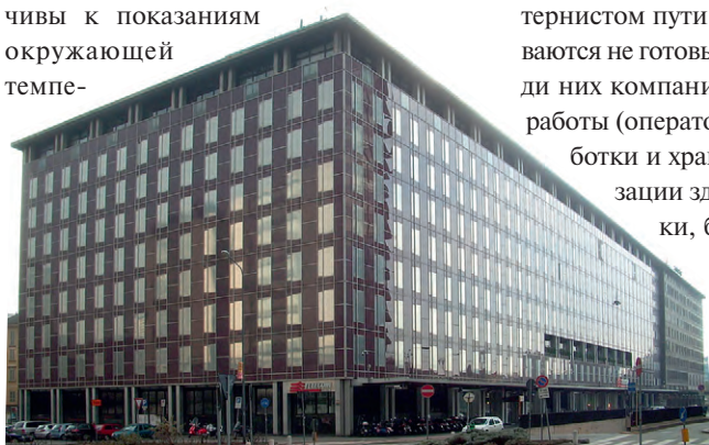
Рис. 1. Здание штаб-квартиры Telecom Italia
