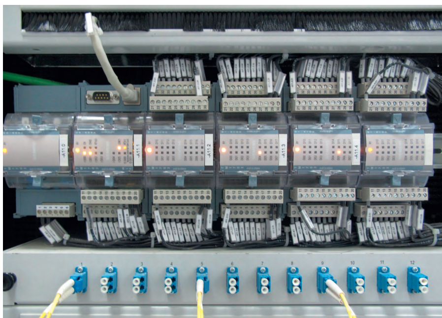
Рис. 3. Контроллер TM 1703
