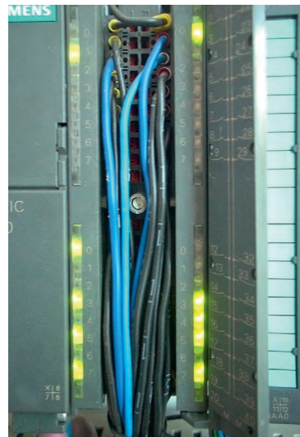
Рис. 3. Подключение входов и выходов контроллера
