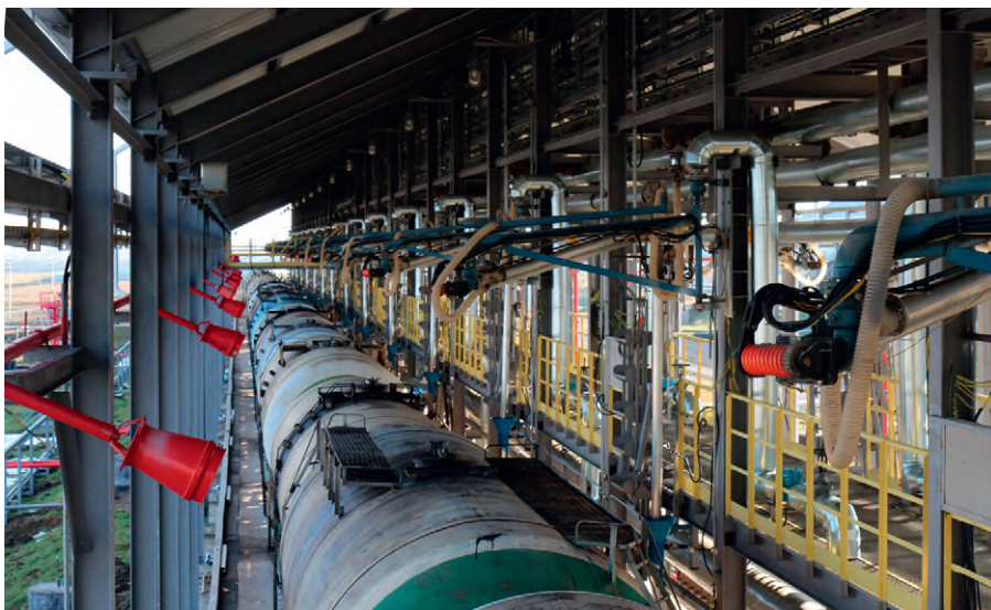
Рис. 1. Железнодорожная эстакада слива-налива нефтепродуктов ООО «Ильский НПЗ»
