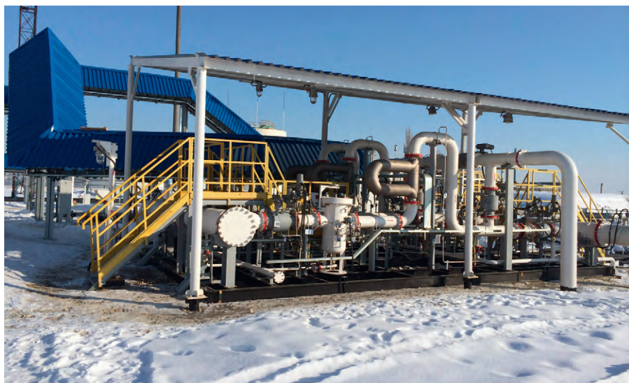
Рис. 1. Узел коммерческого учёта нефти
