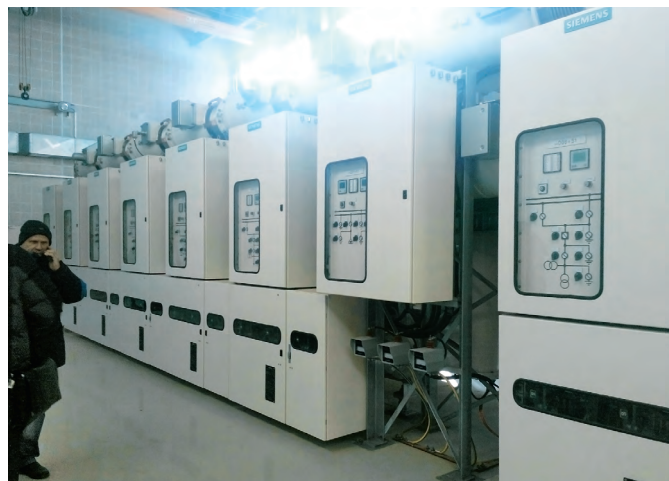
Рис. 2. Комплектное распределительное устройство (КРУЭ)
