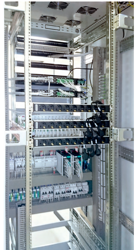
Рис. 4. Основное оборудование СОТИ АССО, шкаф 00CF01 (ГК)
