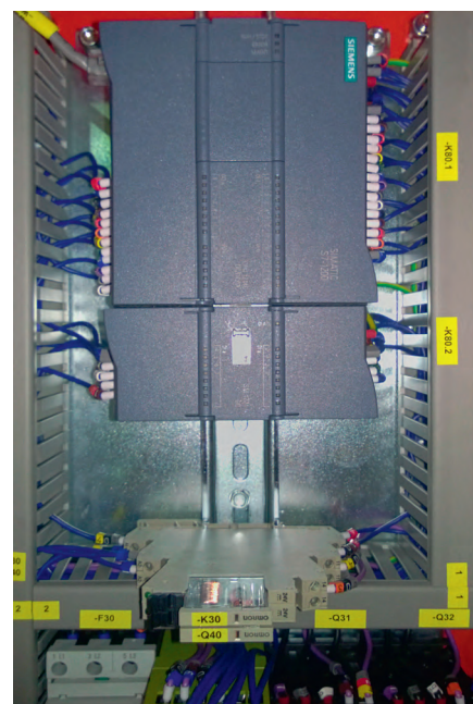
Рис. 6. ПЛК SIEMENS S7-1200 с модулями расширения
