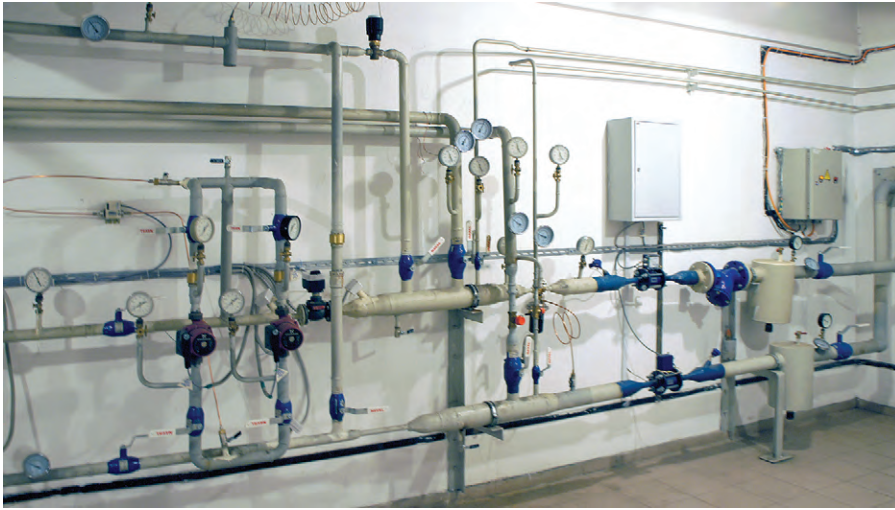
Рис. 3. Индивидуальный теплопункт
