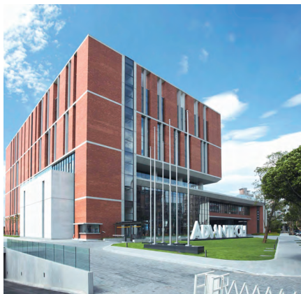
Здание головного офиса компании Advantech
