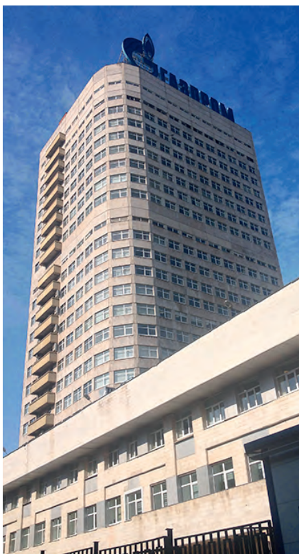
Рис. 1. Бизнес-центр «Газпром Энергодом»
