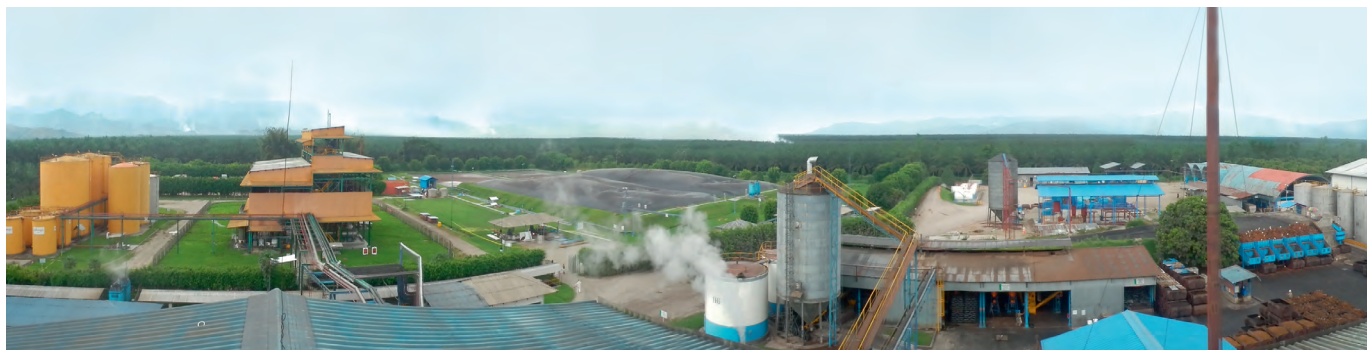
Рис. 4. Биогазовая станция в Перу ↑→
