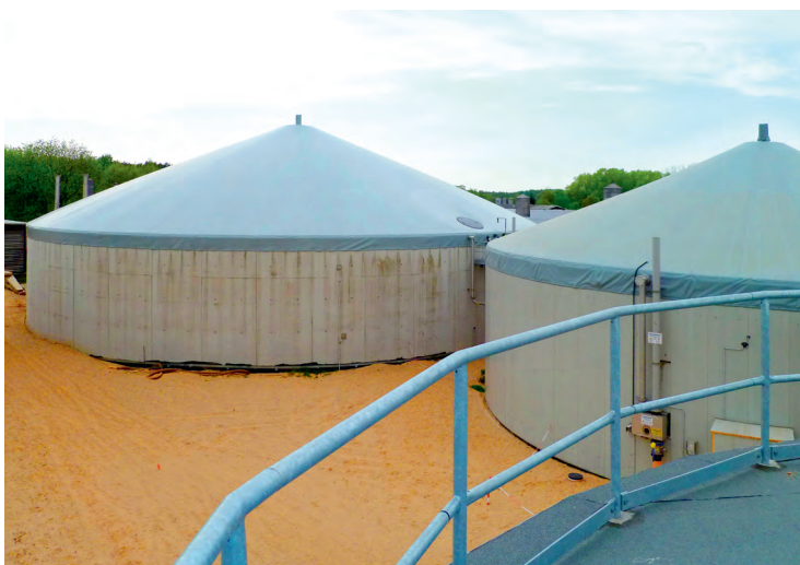
Рис. 1. Вид типовой биогазовой станции
