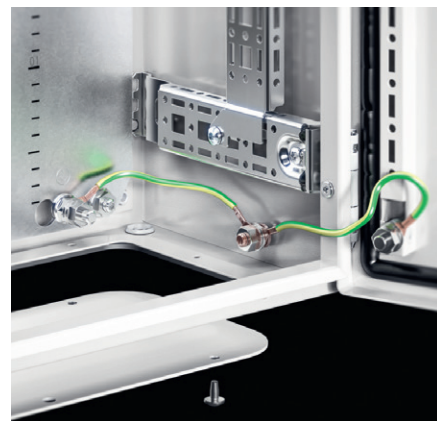
Рис. 13. Заземление монтажной панели после сборки
